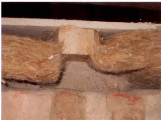
Fig.5: realizzazione in opera delle contropareti interne. (Foto di arch. Enrico Goberti)
